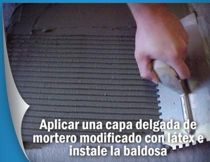
Aplicar una capa delgada de mortero modificado con látex e instale la baldosa
