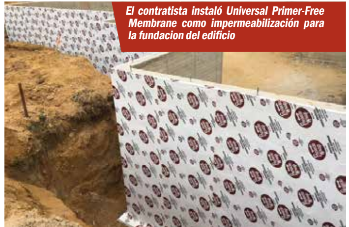
Instalado como banda de nieve para proteger el revestimiento y instalado hacia abajo sobre la fundación para sellar completamente la placa del umbral manteniendo afuera el aire, la humedad, las alimañas e insectos
