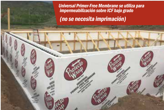
Universal Primer-Free Membrane utilizado como barrera de aire y vapor donde el punto de rocío se ha diseñado para el exterior de la envolvente del edificio.
