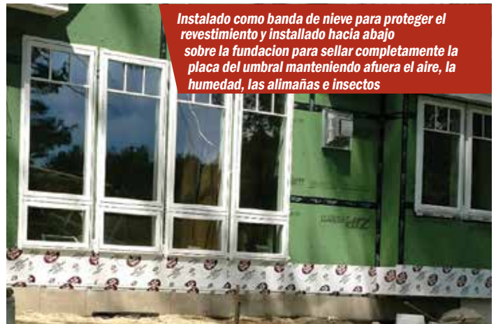
Universal Primer-Free Membrane utilizado como barrera de aire y vapor donde el punto de rocío se ha diseñado para el exterior de la envolvente del edificio.
